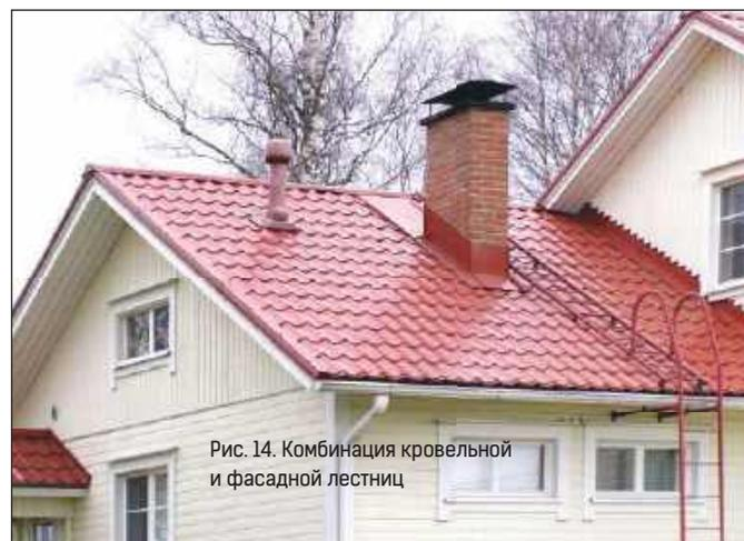
Рис. 14. Комбинация кровельной и фасадной лестниц
