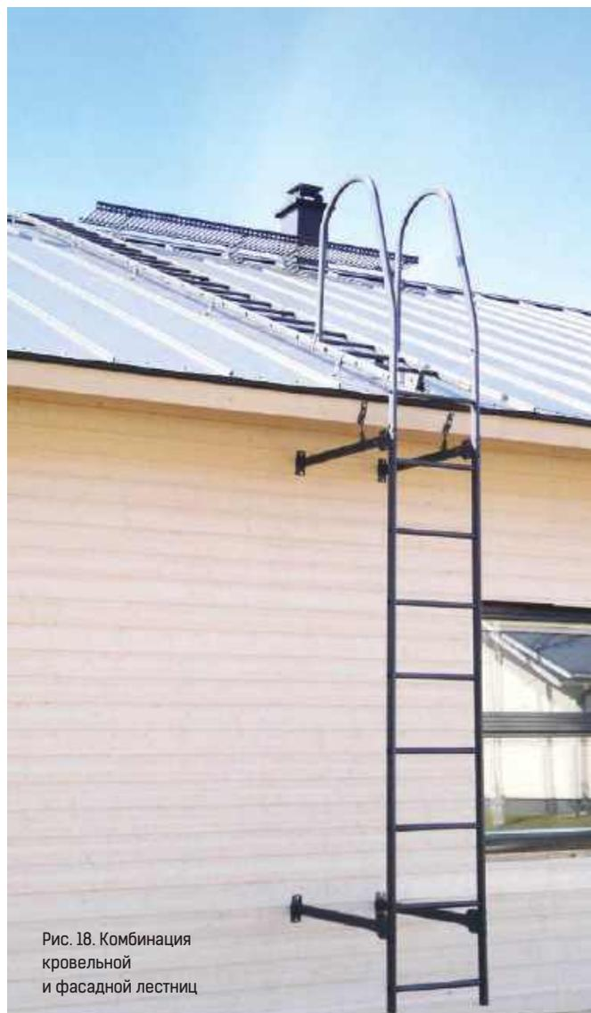
Рис. 18. Комбинация кровельной и фасадной лестниц
