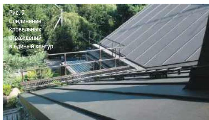
Рис. 9. Соединение кровельных ограждений в единый контур
